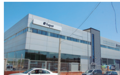
Nou edifici al c/ Provença.
